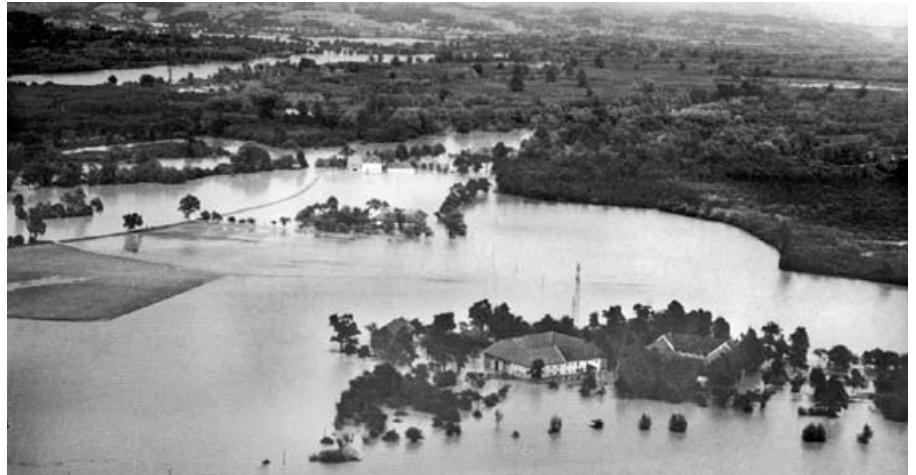
Abb. 2: Die an das Hirschgebiet westlich angrenzende Schwaigau und der gesamte Aubereich steht Anfang Juli 1954 großflächig unter Wasser. Im Vordergrund die Bauernhäuser Eberl und Forster, im Hintergrund die Donau. Foto: www.Lentia-Verlag.at.
