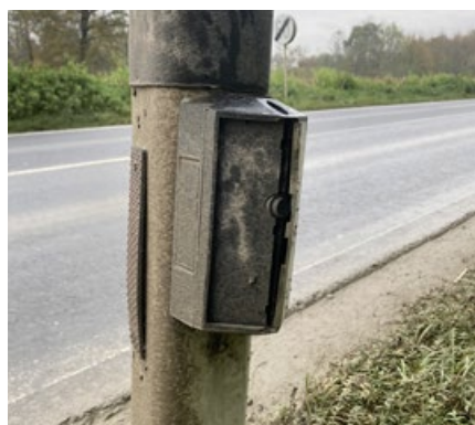
▲ Verschmutzte und defekte Wildwarner sind nicht funktionstüchtig!
