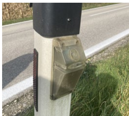
▲ Auch die Montage muss richtig erfolgen! Hier ein verkehrt montierter Wildwarner.
