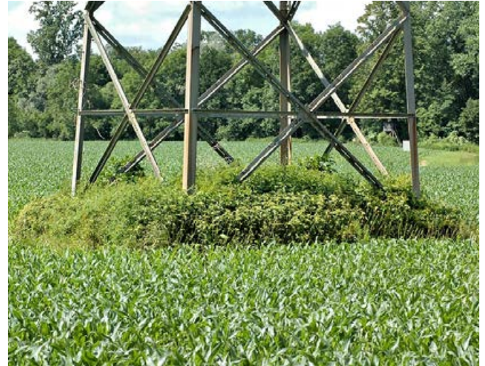
▲ Abb. 2: Ein in der Nähe einer Hecke oder eines Waldstückes bepflanzter Mastfuß wird durch die Anbindung an andere Deckung als ökologische Falle entschärft.
